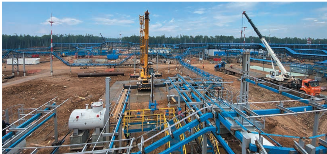
Строительство КС-2К «Семён Дежнёв», октябрь 2024 года
