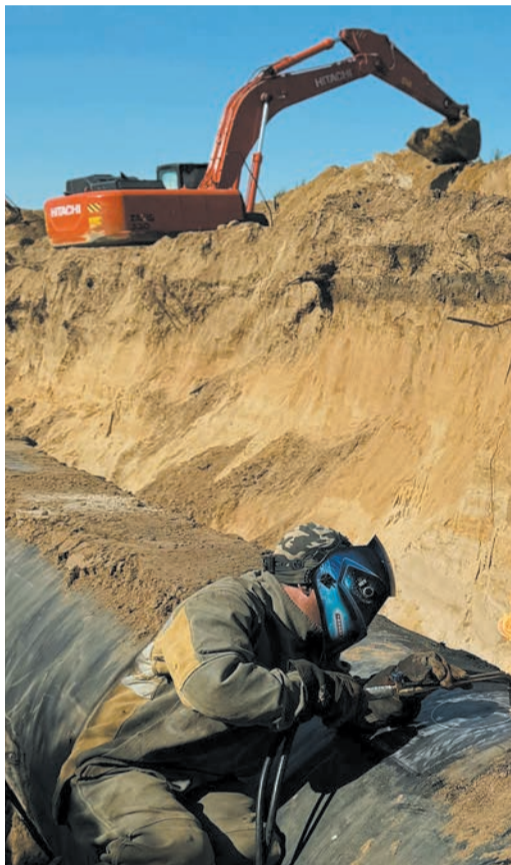
Вырезка технического отверстия – важный и ответственный этап
