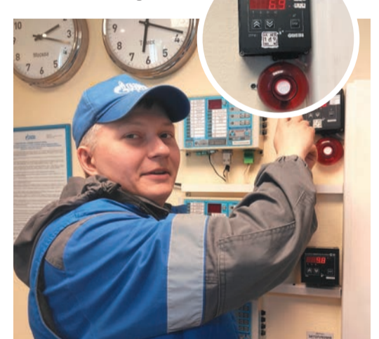
Слесарь по КИПиА Амурского ЛПУМГ Андрей Котов демонстрирует контроллер-регулятор и светозвуковой оповещатель, которые помогают предотвратить перегрев оборудования
