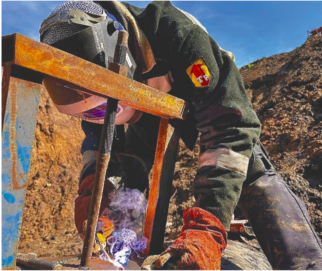
Красота сварки от специалистов Новокузнецкого ЛПУМГ
