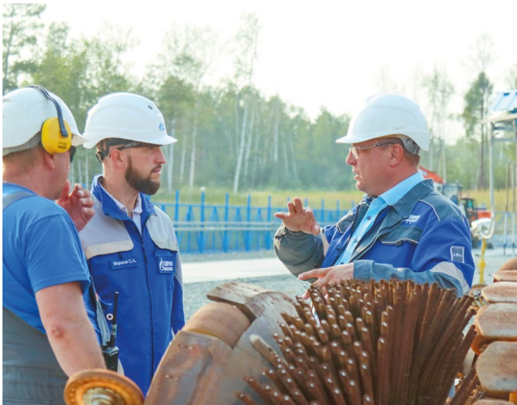
Внутритрубная дефектоскопия участка лупингов МГ «Сила Сибири»
