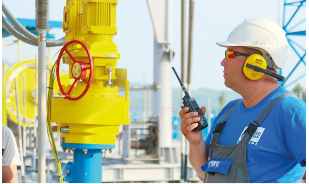
Плано-предупредительные ремонтные работы летом проходят на магистральных газопроводах от Омска до Хабаровска
