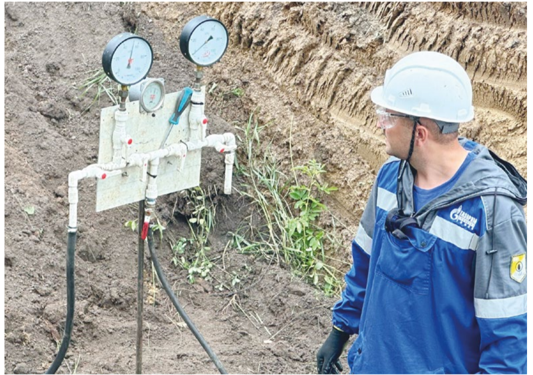
Огневые работы на газопроводе-отводе к ГРС-4 города Омска
