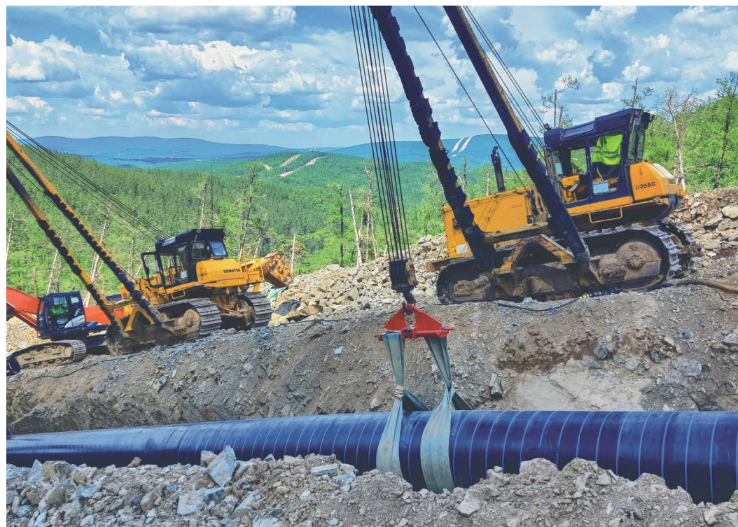
Строительство лупингов МГ «Сила Сибири»
