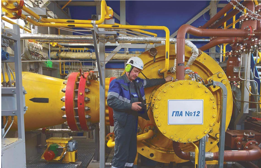
Специалисты ИТЦ измеряют уровень вибрации оборудования на компрессорной станции «Иван Ребров»
