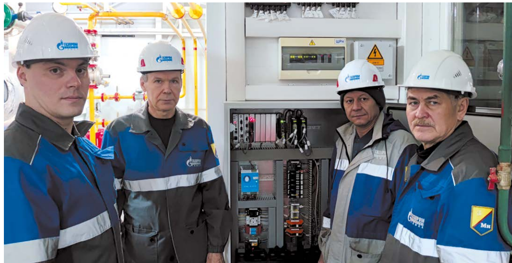
Работники Томского ЛПУМГ рядом с новой системой мониторинга оборудования котельных
